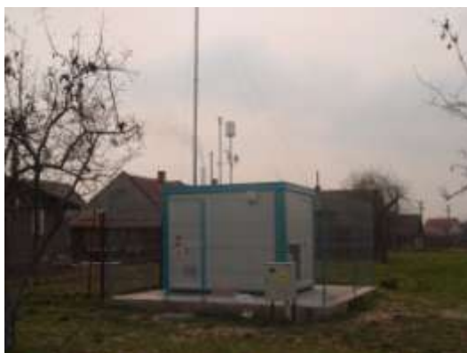
Stație automată de monitorizare a calității aerului
