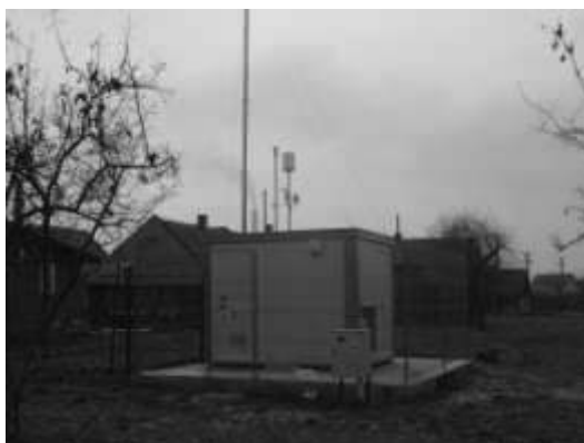
Stație automată de monitorizare a calității aerului
